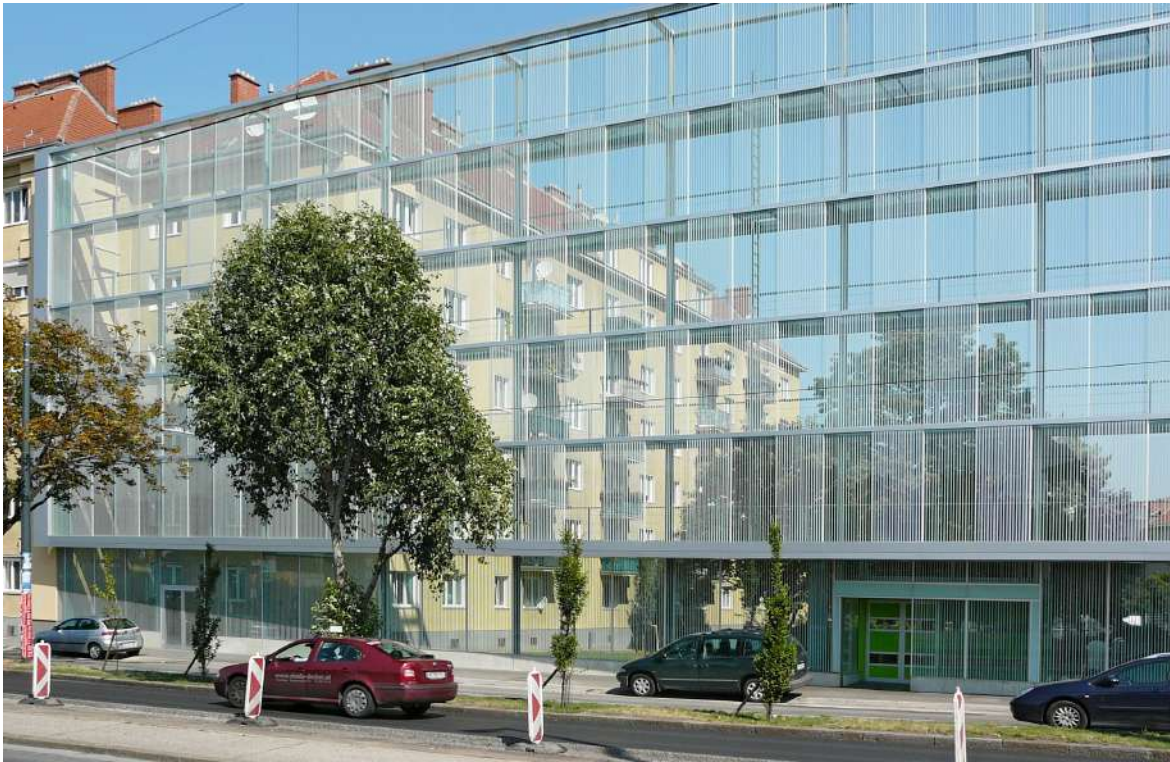
La structure en trois dimensions de la paroi anti-bruit conçue au Theodor-Körner-Hof à Vienne par Treusch architecture est volontairement mise en évidence par la trame appliquée pour protéger les oiseaux.
