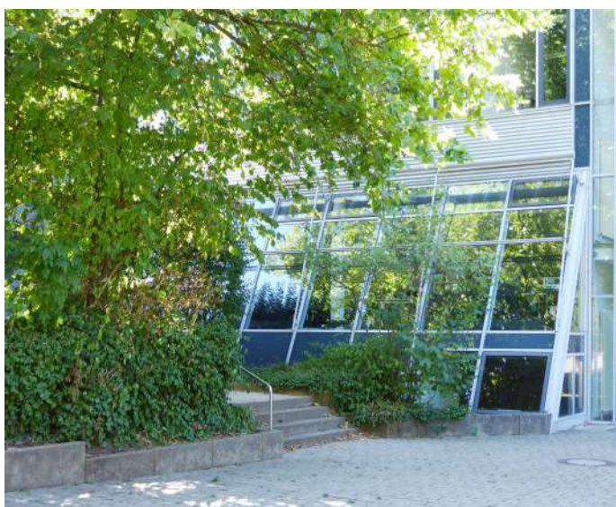
Les reflets de la façade vitrée inclinée de cette école sont aussi clairs que si la paroi était verticale, et présentent donc un risque élevé de collision.
