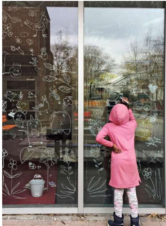
Les motifs de ce marquage créatif seront répartis sur toute la surface et ne laisseront pas de grandes lacunes. Ils gênent peu la vue vers l'extérieur, et n'empêchent pas la lumière d'entrer.
