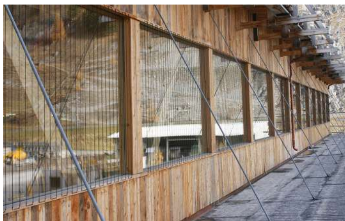
Après des collisions d'oiseaux répétées contre les fenêtres d'un atelier de S-chanf (Suisse), des fils de nylon espacés de 8-10 cm ont été tendus. Aucune collision n'a été enregistrée après l'installation.
