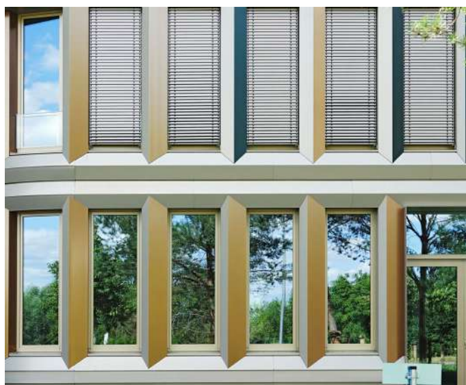
Fermés, les stores extérieurs peuvent prévenir les collisions. Ce n'est toutefois pas une solution durable, puisqu'elle dépend de l'utilisation qui en est faite.
