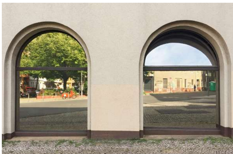
Les films de protection solaire réfléchissants produisent des images reflétées très fidèles : les oiseaux prennent ces fenêtres pour des passages ouverts.
