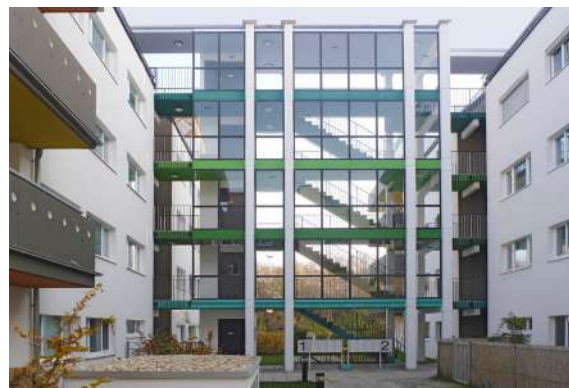
Le danger posé par les parois et passerelles vitrées est aggravé lorsque les oiseaux sont inéluctablement orientés en direction de l'obstacle vitré.
