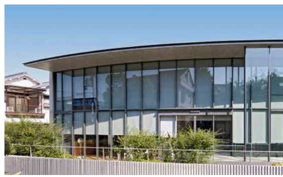
Si les jalousies intérieures et les panneaux clairs posés derrière les vitres peuvent réduire la réflexion, il y a souvent des reflets et cela reste peu efficace contre les collisions. Il ne faut pas compter sur une telle protection contre les collisions, d'autant plus que les stores ne sont pas baissés en permanence.
