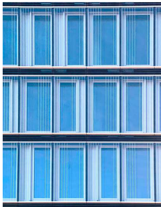
Même si les parois vitrées ont été équipées de marquages testés comme efficaces pour la protection des oiseaux, les grands espaces laissés vierges rendent les collisions toujours possibles.
