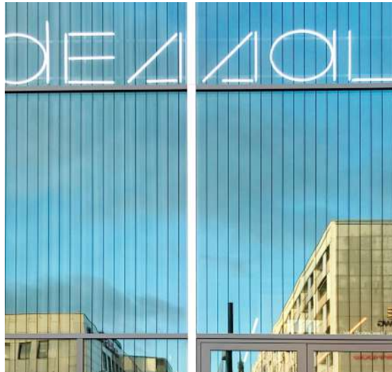
Pour lutter contre les collisions d'oiseaux, le nouveau Bauhaus Museum de Dessau (Allemagne) a couvert après coup plus de 2700m 2 de façade vitrée d'un motif ligné découpé.
