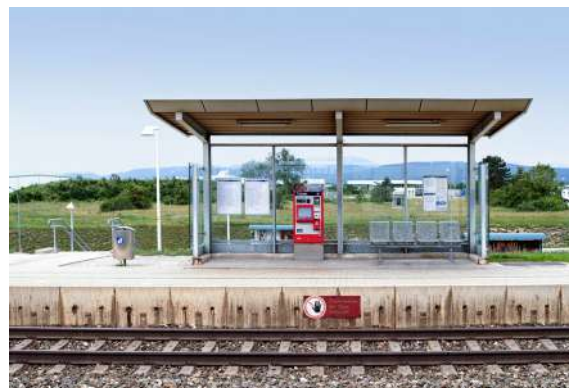
Les abris de transports publics sont très souvent conçus en verre, sans que l'on ne pense à des mesures de sécurité pour les oiseaux.
