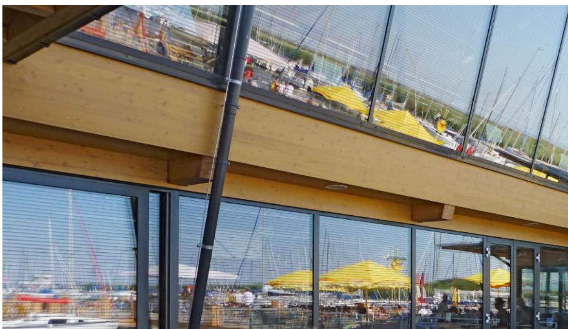
Les vitres de ce restaurant du parc national du lac de Neusiedl (Autriche) sont munies d'une impression de fines rayures noires.
