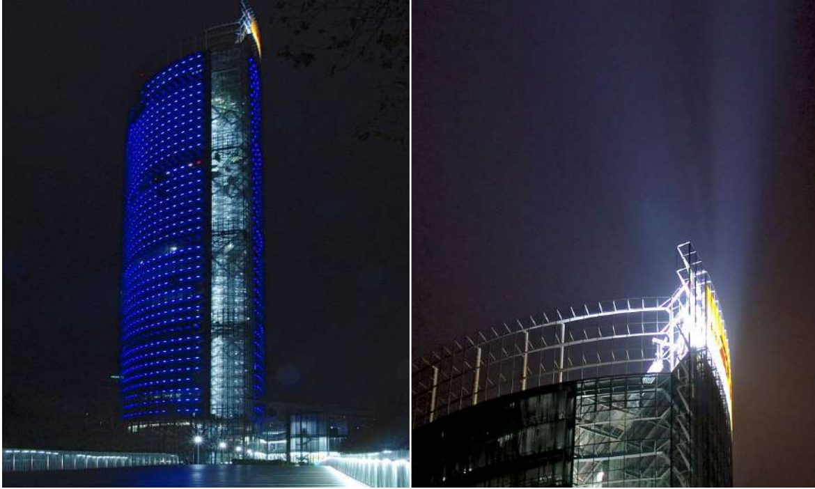
Les effets de lumière derrière la façade vitrée et les enseignes lumineuses sur le toit de la Post Tower de Bonn attirent les oiseaux migrateurs dans un piège mortel. Ce type de supports publicitaires lumineux, grues, signaux de sécurité aérienne et autres sources de lumière très en hauteur se trouvent sur les trajectoires de vol des oiseaux, et recèlent un potentiel de danger largement méconnu jusqu'à présent.
