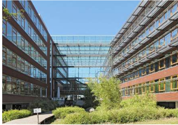
Les cours intérieures végétalisées, ou les zones entourées de bâtiments, augmentent le risque de collision contre les surfaces vitrées. Depuis le ciel, la végétation au milieu d'un océan d'habitations attire les oiseaux. En revanche, le décollage avec un angle élevé peut être difficile.
