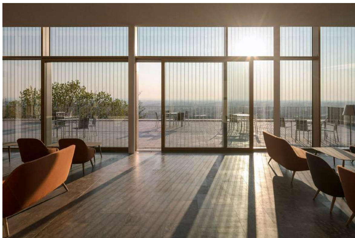
A l'occasion des transformations de l'abbaye de Michaelsberg (D), édifice protégé, des marquages hautement efficaces pour la protection des oiseaux ont été intégrés à la planification en tant qu'éléments architecturaux par caspar.architects.
