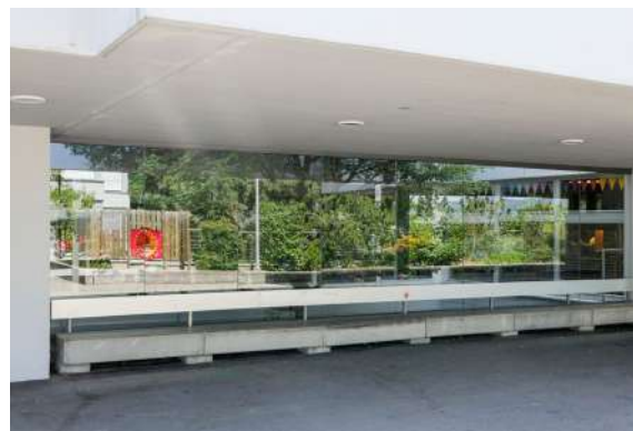
Bien que les fenêtres soient en retrait de plusieurs mètres, on voit clairement des reflets. L'ombre portée n'élimine pas la réflexion.
