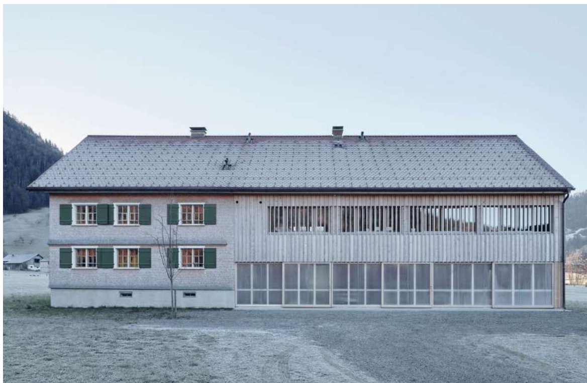
A l'occasion d'une réaffectation, les architectes du bureau gruber locher ont profité de l'assainissement de la maison Grossenbündt à Hittisau (Autriche), classée, pour abriter les locaux d'exploitation derrière un espace semi-transparent. La structure de la façade en bois traditionnelle a été prolongée par-dessus la longue rangée de fenêtres à l'étage supérieur, pour protéger du soleil, tandis que les fenêtres classiques de la partie habitation ont été conservées. Les oiseaux peuvent identifier sans problème ces matériaux et ces structures.
