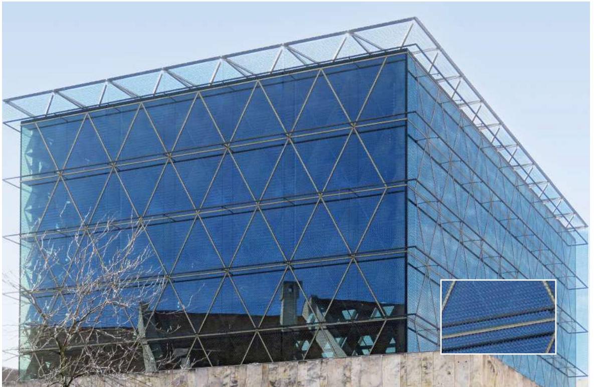
Le cube de verre du centre juif de Wandel Hoefer Lorch + Hirsch à Munich est entouré d'une structure en acier et d'un maillage en bronze. Un motif de triangles rappelant l'étoile de David apporte une atmosphère particulière au lieu de prière, grâce au jeu de lumières et d'ombres.
