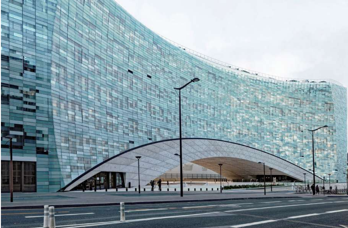
La façade du siège du groupe Le Monde, réalisée par Snøhetta à Paris, est faite de plus de 20 000 éléments de verre. Ils varient dans la structure et dans la transparence et sont ainsi arrangés pour que la lumière dans les bureaux et la vue au-dehors soient optimisées.
